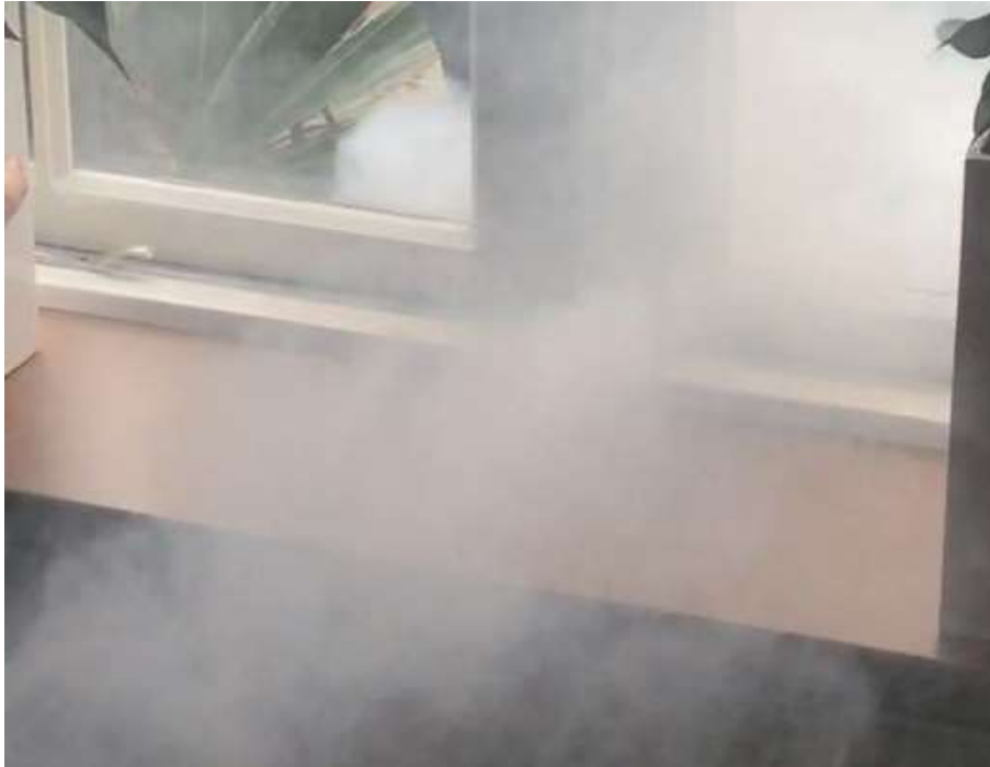
Raamkozijn voorgevel woonkamer
